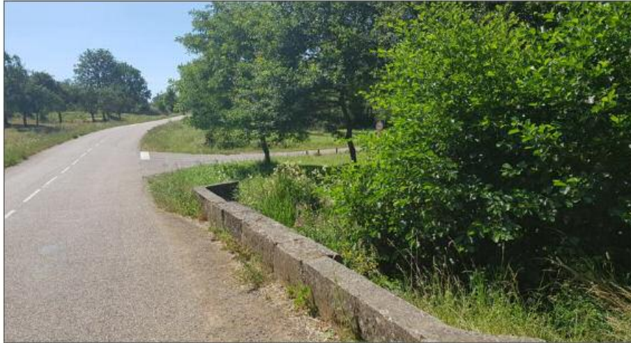
Sur cette photo, trois problèmes : un virage serré, un muret dangereux si une voiture ou une moto tape dedans et l'absence de trottoir alors qu'un chemin pédestre incite les piétons à passer par là.
