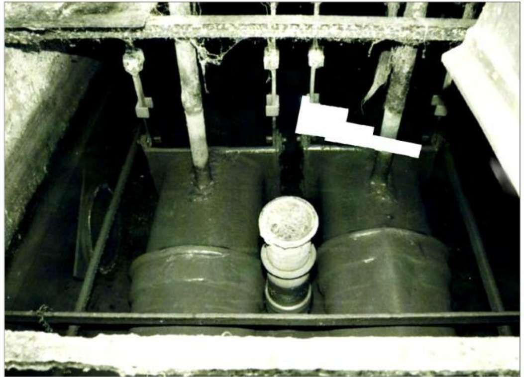
Deux conduites en fonte faisant office de siphon. Photo DR
