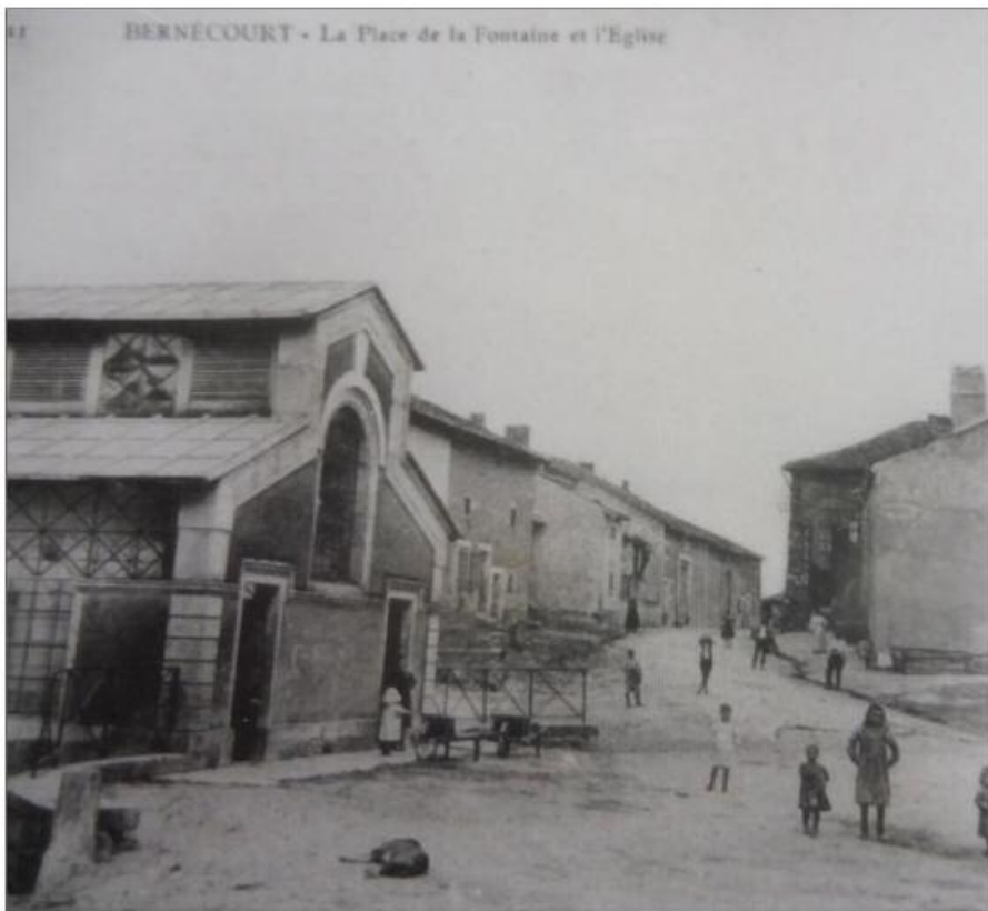
Edifié en 1886, le lavoir a été très endommagé en septembre 1914.
