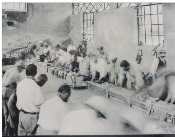
Une vingtaine de laveuses pouvait y travailler en même temps. De solides bancs en pierre longeaient les murs.
